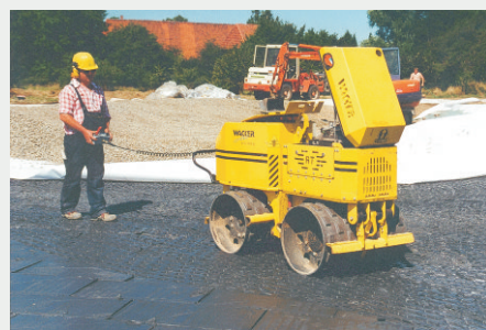
Die Tondichtung wird verknüpft, mit Vlies und 30 cm Kies überdeckt
