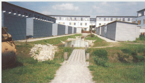
Regenwassersammlung und Rückhalt in dem Baugebiet; Übergabe in den Sammelgraben
